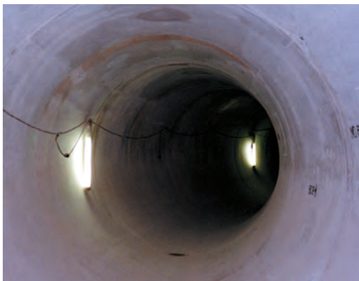
橋良雨水幹線・直径2.4m (平成9年度完成)
