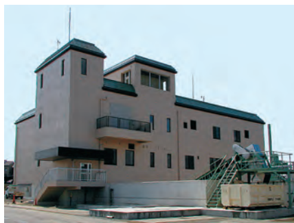
下地ポンプ場 [雨水] 豊橋市下地町地内 (平成16年度運転開始) 雨水排水能力 709m 3 /分
